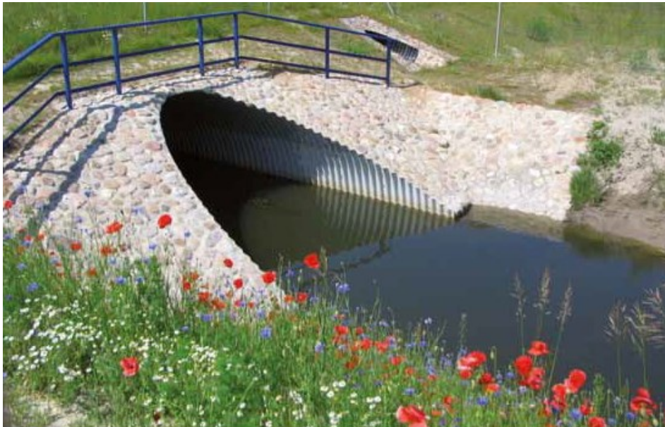
Obr. č. 14. Pohľad na výtok tlamového priepustu z vlnitého plechu so šikmým prstencom po obvodu z dlažby z lom. kameňa.
